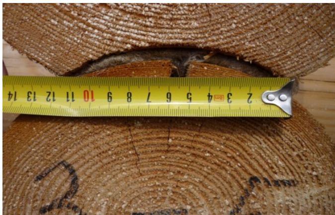
Рис. 3.15. Замеры толщины швов между венцами бревенчатой стены
