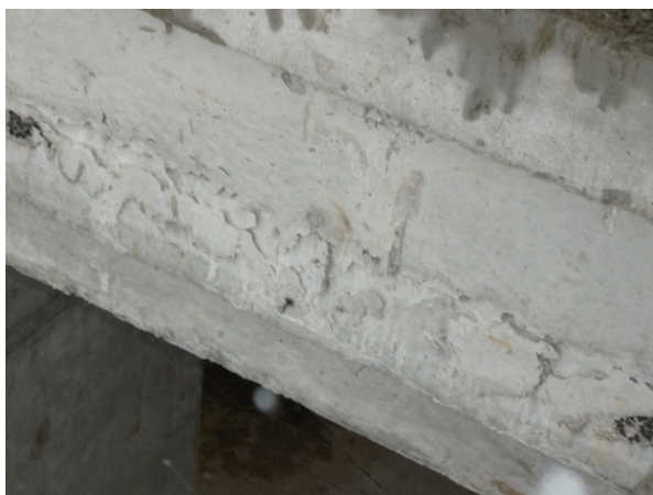
Рис. 3.4. Наплывы бетона
