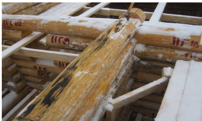
Рис. 3.16. На поверхности бревна видны следы гниения
